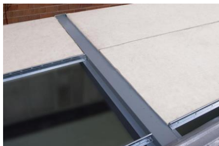
Top Hat Installation
